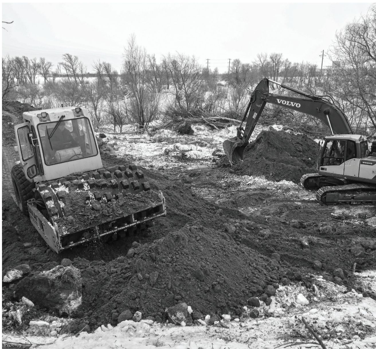
В 5-м Южном переулке кипит работа: техника САХа завозит грунт, утрамбовывает и наращивает насыпь. //Фото Василия БАРАНОВА.
