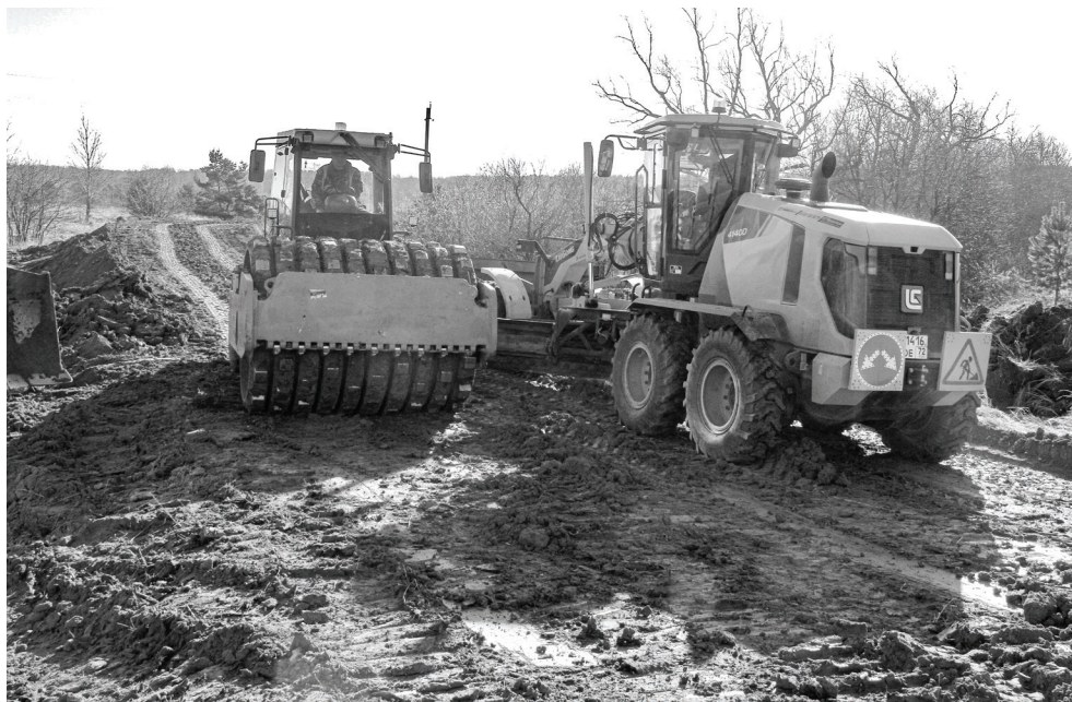
На территории Синицынского бора возвели две земляные насыпи: одна защитит дорогу Ишим – Синицыно и п. Детский дом от воды, а другая – п. Дом отдыха. // Фото автора.
