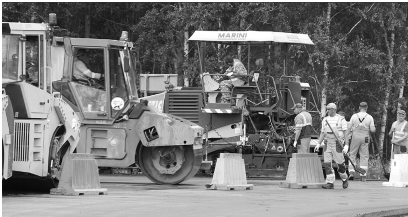
Последние штрихи дорожного ремонта на кольце на въезде в посёлок
