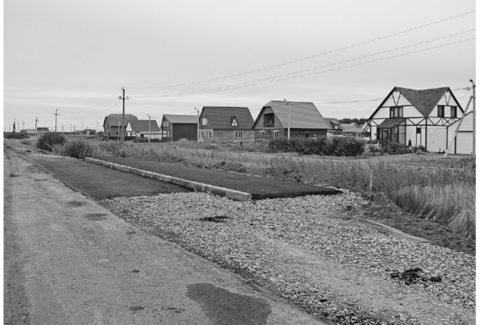
* Оборудованная площадка в Сладкове.
