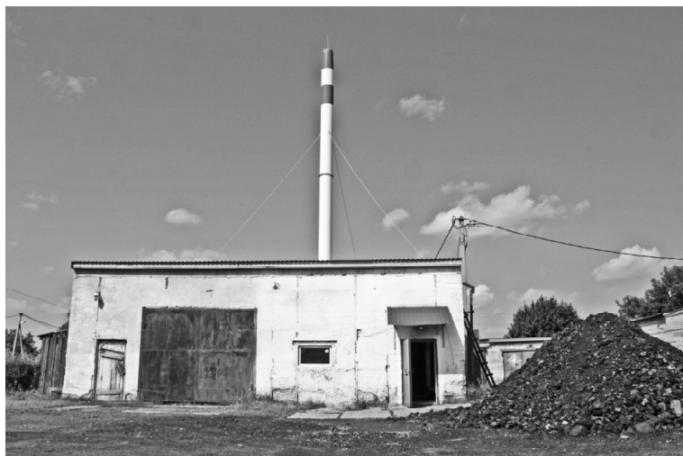
➤ Котельная, с. Озерное
