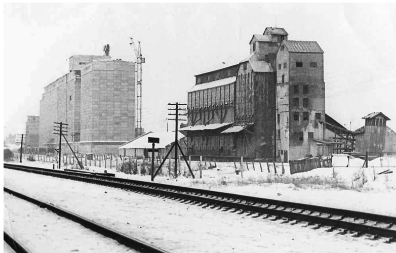
Уникальное фото Голышмановского элеватора. Рядом с новым корпусом КХП, построенном в 1980-м, ещё стоит прежнее здание элеватора 1960-х годов
