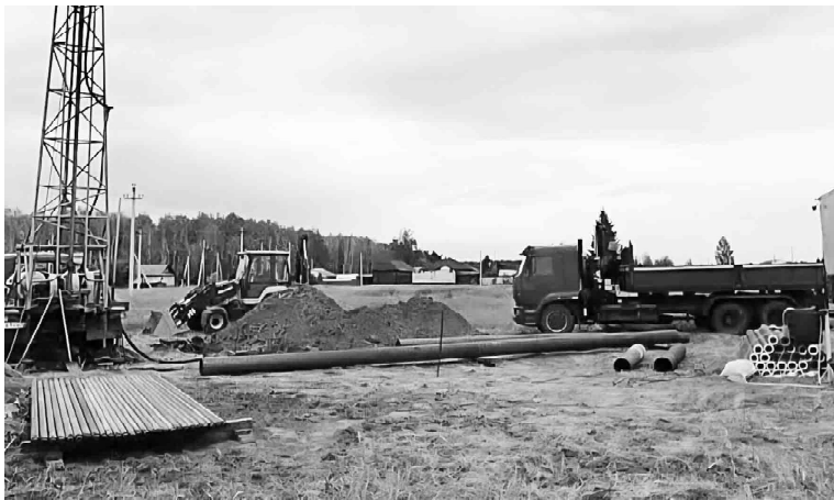
Работы проведены в короткие сроки
