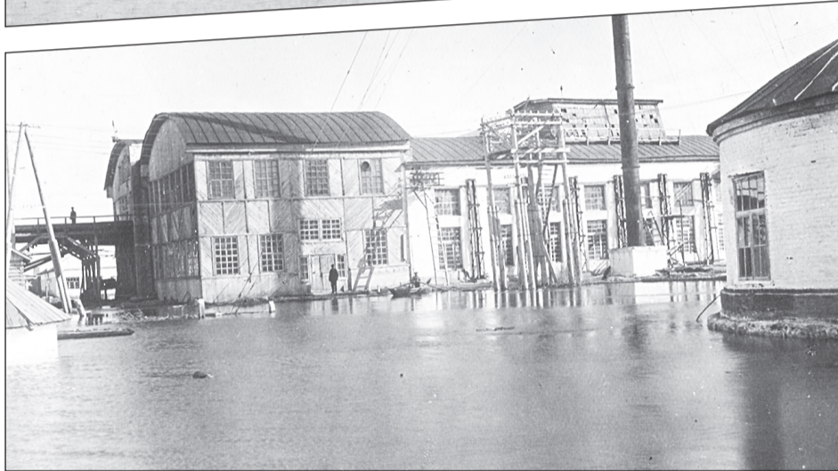
Цеха лесозавода буквально плавали в воде
