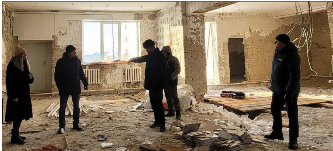
• В этом году на объекте планируется выполнить ремонт кровли, отопления и монолитных участков здания.
