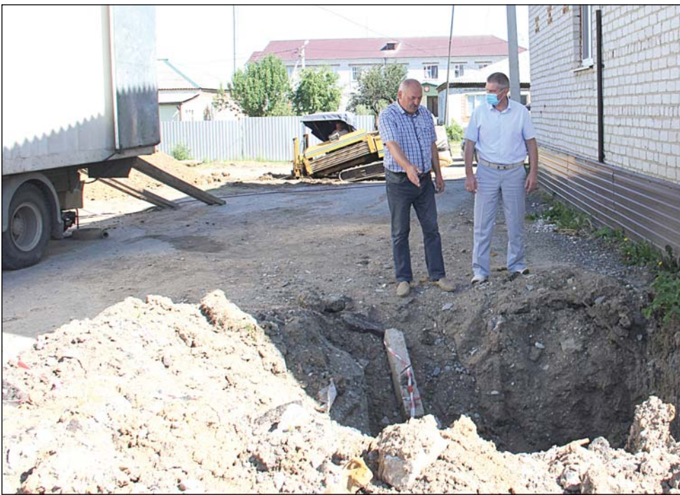
• ООО «Сибгазсервис» проводит замену тепловых сетей.
