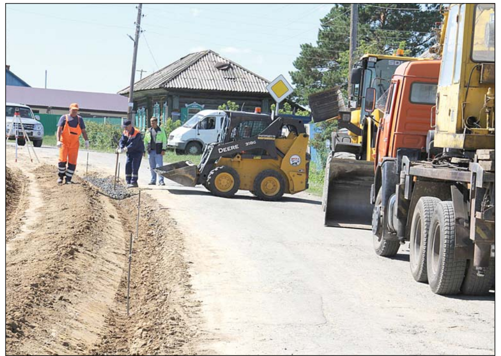
• В Слободчиках ведётся ремонт дорог и тротуаров.
