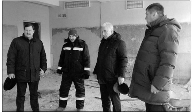
В здании Каскаринского ДК, где побывал депутат, идет ремонт.
