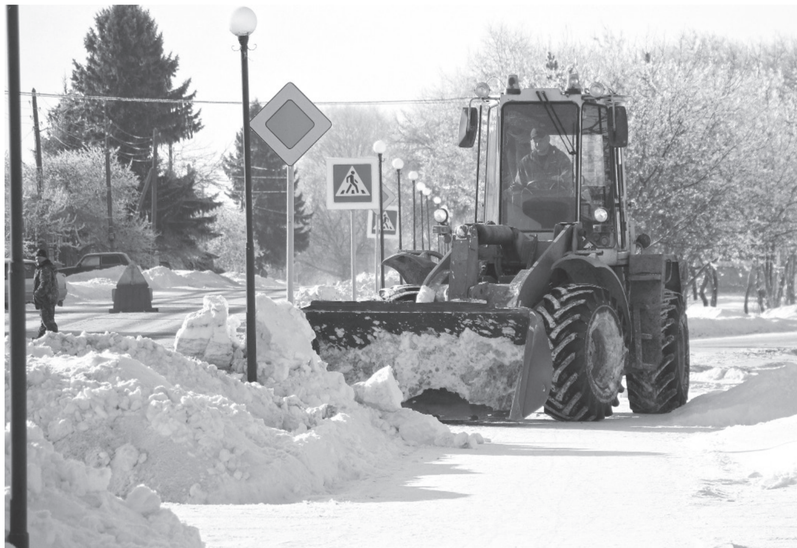
Дорожники очищают улицы от снежных завалов.
