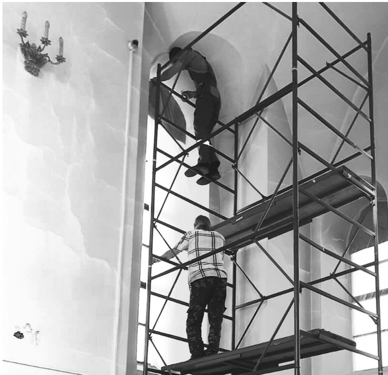
Прихожане ремонтируют стены внутри основного помещения храма, покрывшиеся тонкими трещинами
