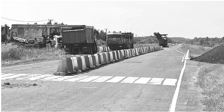
На снимке: Ремонт дороги продолжается / ФОТО: АРХИВ
