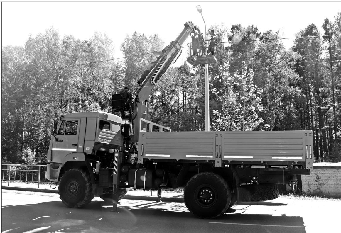
❗ Работники подрядной организации не тратят времени даром. Монтаж новой линии освещения на улице Декабристов в Заводоуковске идёт полным ходом. /ФОТО АВТОРА
