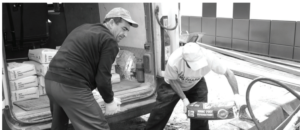
Капитальный ремонт провели на первом этаже и во дворе школы. // Фото Василия БАРАНОВА.
