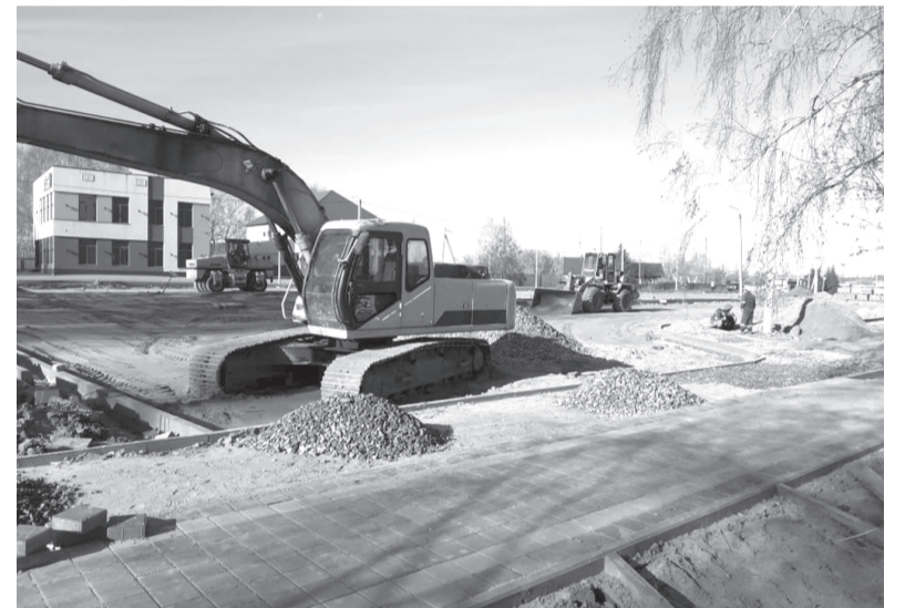
На будущей парковке кипит работа
