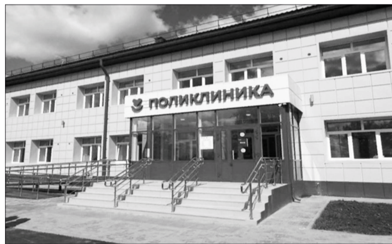
Поликлиника после капитального ремонта в с. Абатское
