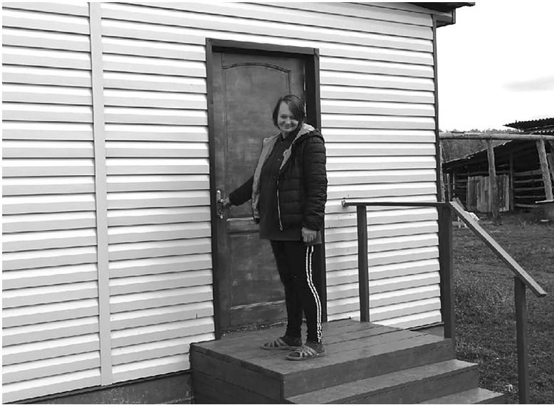
Многодетная мама Ирина Шабалдина из деревни Дербень показывает дом после капитального переустройства
