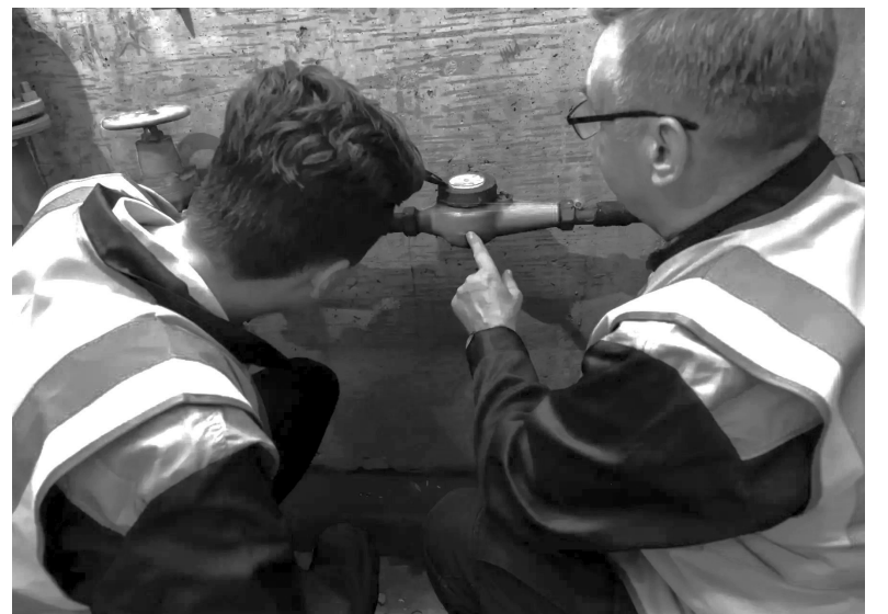
Коммунальщики контролируют давление в системе после запуска нового оборудования
