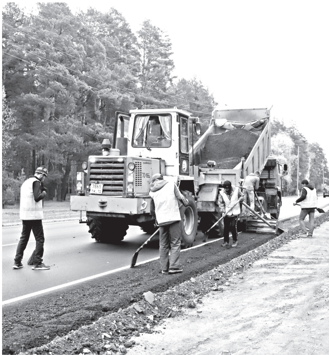
• Рабочие ООО «Артстрой» проводят завершающий этап ремонта проезжей части улицы Шоссейной – отсыпку обочин.
