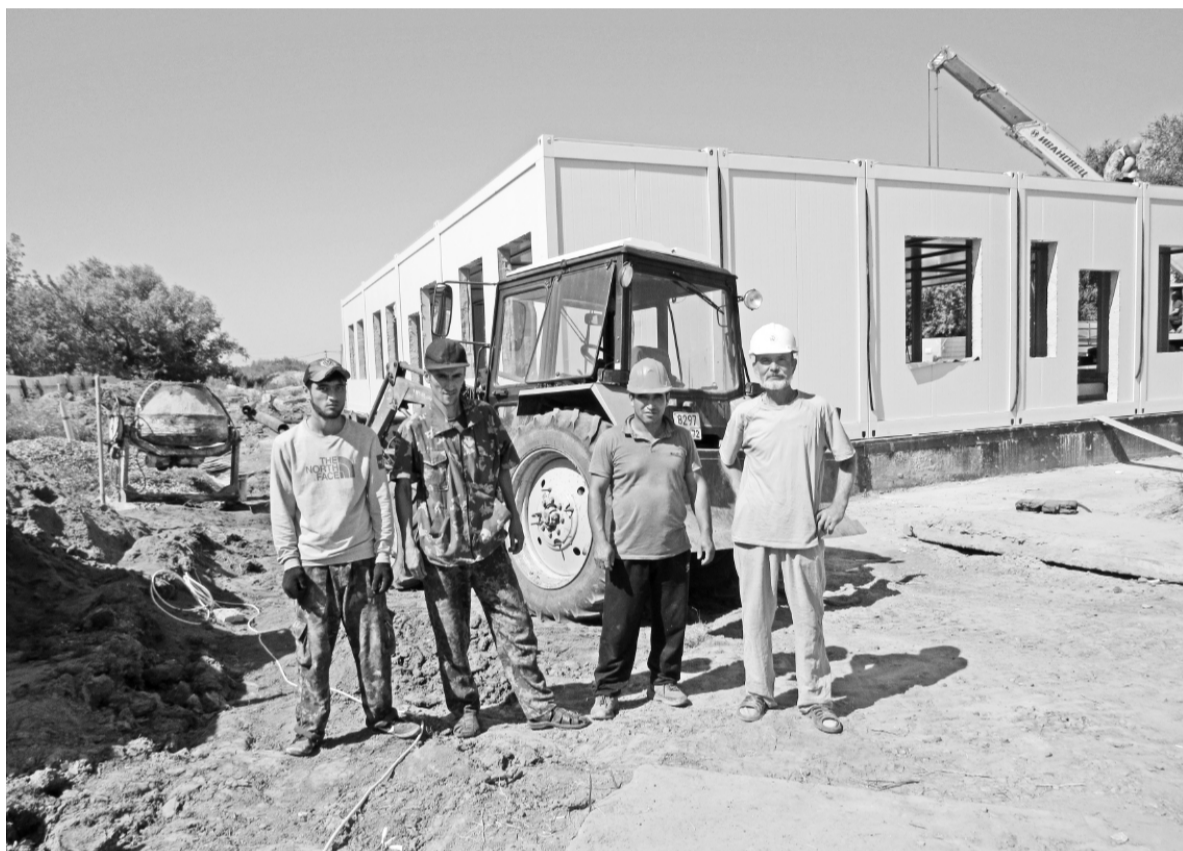
Строительство школы в с. Касьяново идет полным ходом
