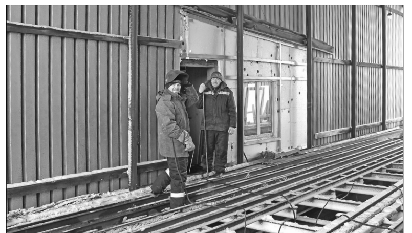
Идёт переоборудование старых рычажных весов, изготовление металлического настила для весов с тензодатчиками
