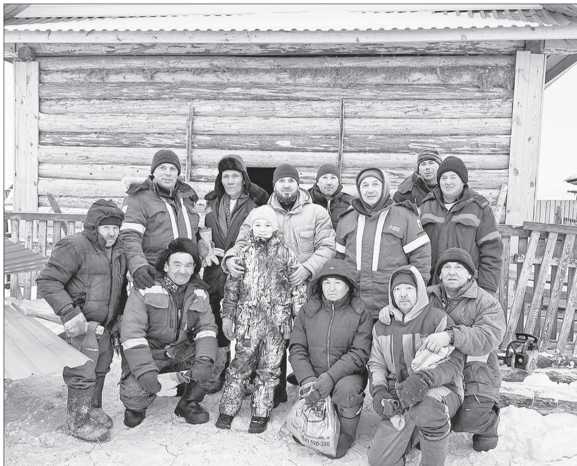
20 января, Кускургуль. Дружной командой во главе с Андреем Халиловым заинтересованные люди продолжили работы по строительству мечети. / ФОТО ИЗ АРХИВА.
