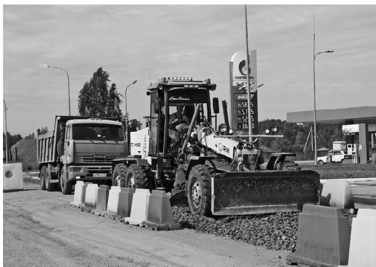
➤ Замена дорожного полотна у автозаправочной станции в Викулово // Фото автора
