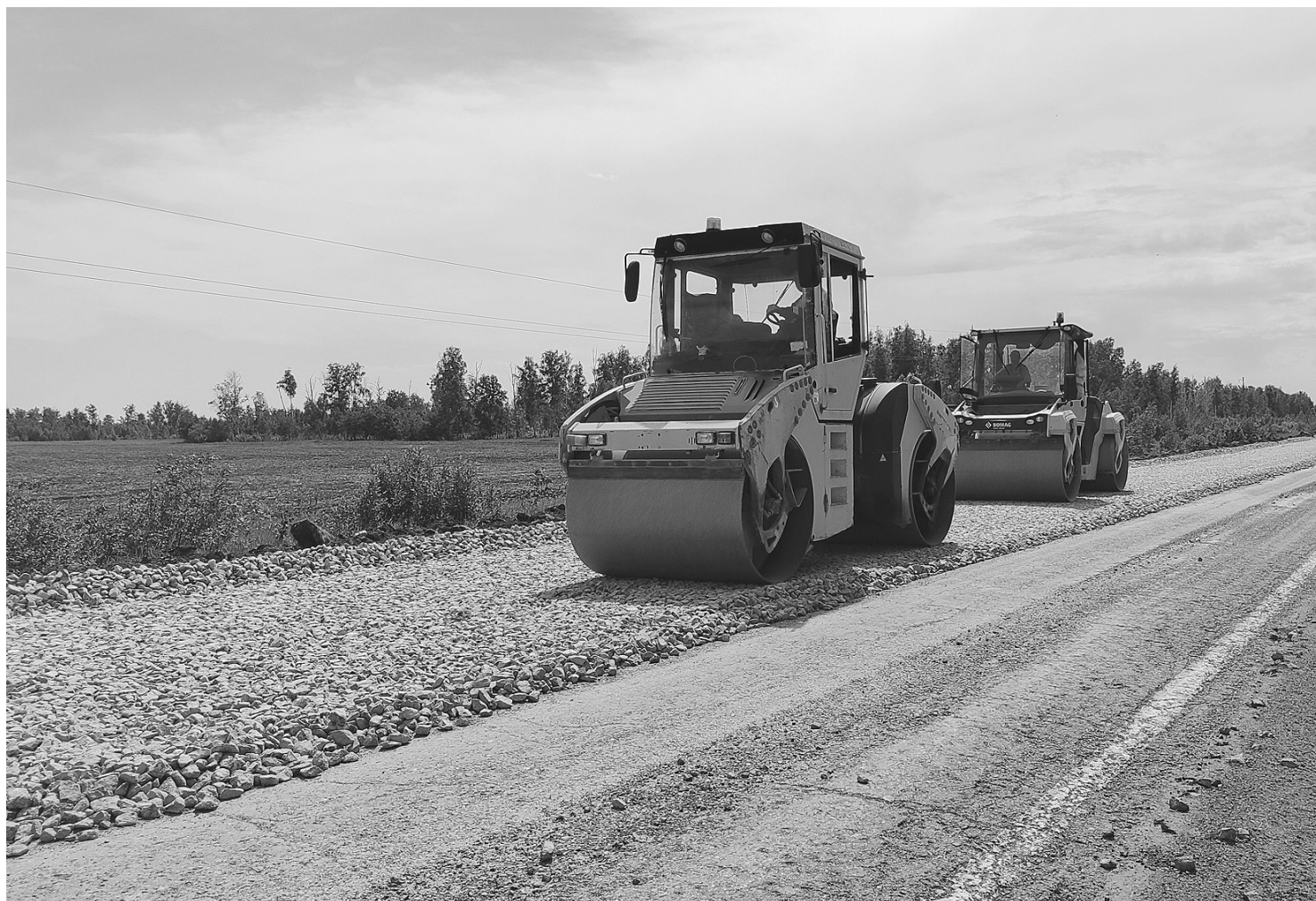
Продолжается ремонт дороги Бердюжье - Уктуз
