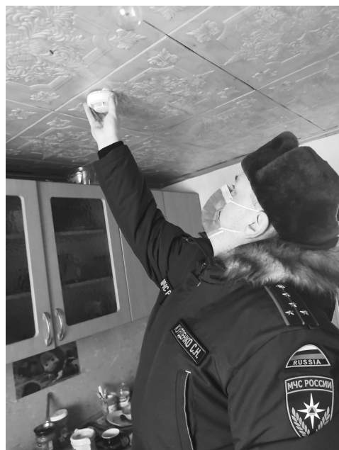
Инспектор ОНД и ПР Сергей Курденко устанавливает пожарный извещатель
