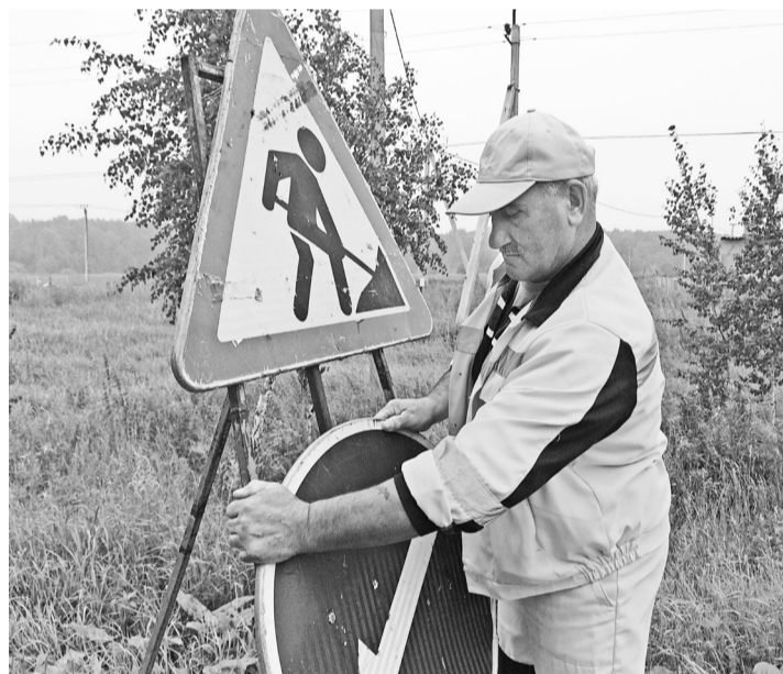
Рабочий Александр Путров устанавливает знак «радно» сообщая, что здесь проводятся дорожные работы.
