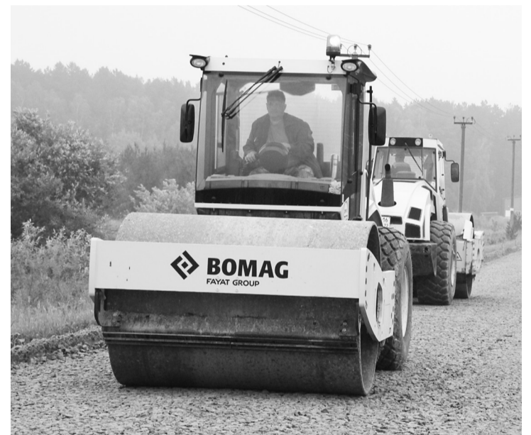
После того, как два катка «отполируют» полотно дороги, можно будет асфальт завозить.
