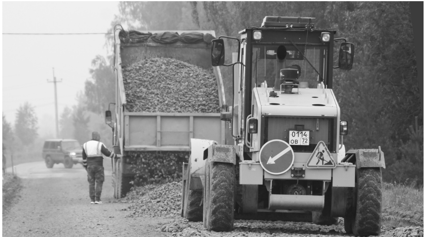
Дорожная техника в действии: самосвалы, разгружающие щебень, работают в связке с грейдерами.
