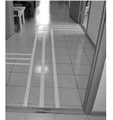
Напольные тактильные ленты – в Отделе ПФР в Сорокинском районе.
