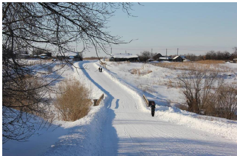
► Отремонтированный мост в Озерном // Фото Татьяны СУХОВОЙ
