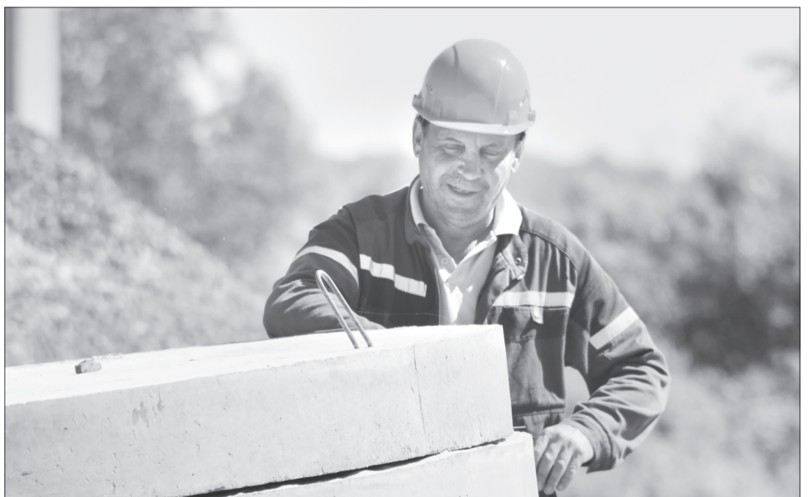
Ялуторовчанин Павел Дементьев продолжает заниматься учётом грунта на большой стройке
