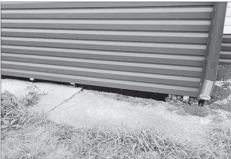
Основание дома: щели в подвал, трещины в отмостке. / ФОТО МАРГАРИТ ПИЛИПОСЯН.
