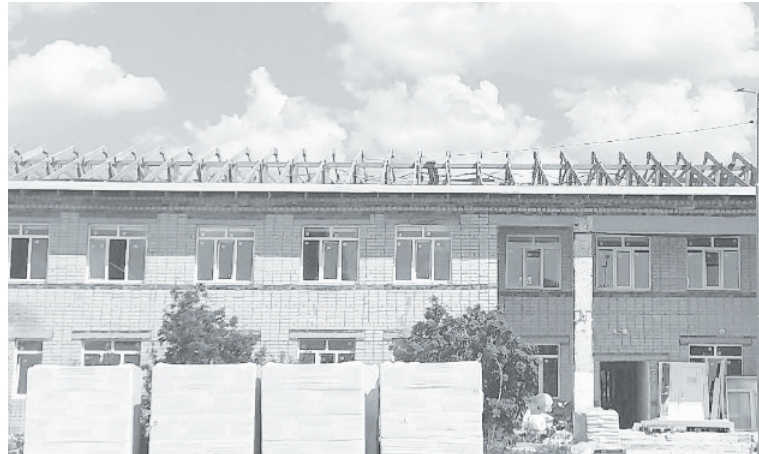
Ремонт здания поликлиники в Упорово идёт полным ходом.
