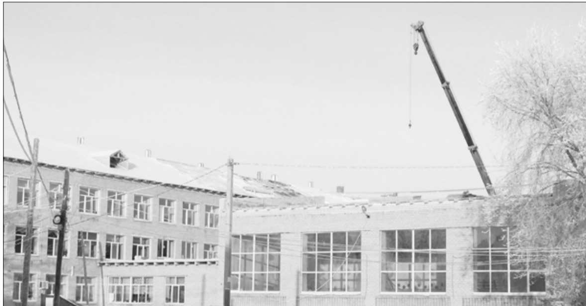
Завершается ремонт кровли Абатской СОШ № 2
