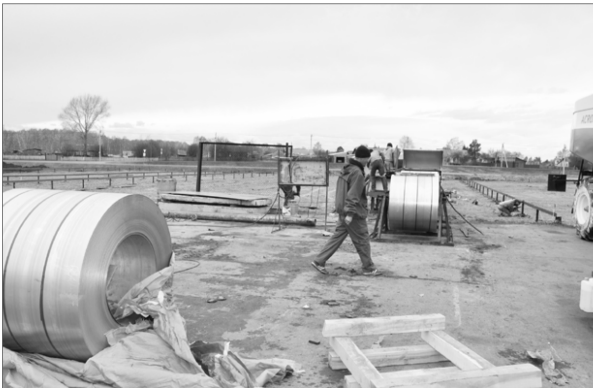
Строительство сушильно-сортировального комплекса в с. Конёво
