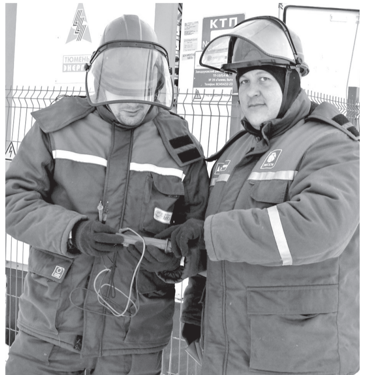
• Электромонтёры Заводоуковской РЭС Павел Ковалёв (слева) и Иван Анисимов готовятся к замеру нагрузок на трансформаторной подстанции.
