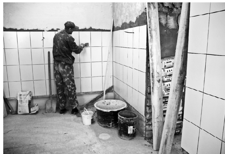
➤ Замена плитки в детском саду
