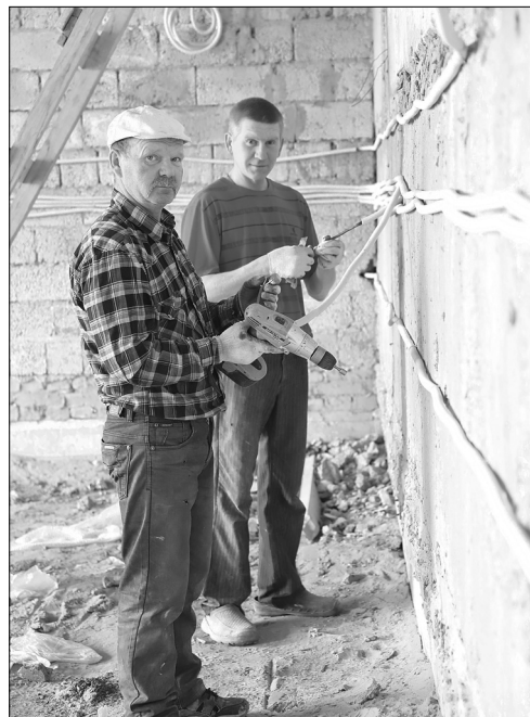
Рабочие Олег Паздерин и Виктор Крек завершают прокладку электрокабеля
