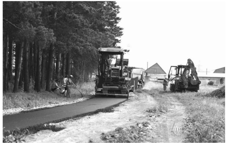
Всего на обустройство велодорожки у работников ДРСУ № 4 ушли 150 тонн асфальтобетона
