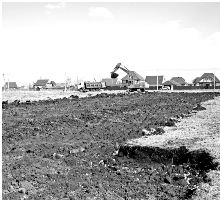
• Апрель 2018 года. Подготовка площадки для строительства школы № 3 в Заводоуковске на улице Летней.
