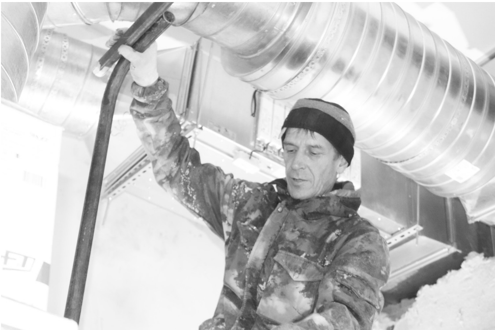
Продолжается монтаж вентиляционной системы, через которую будет обеспечиваться приток тёплого воздуха.
