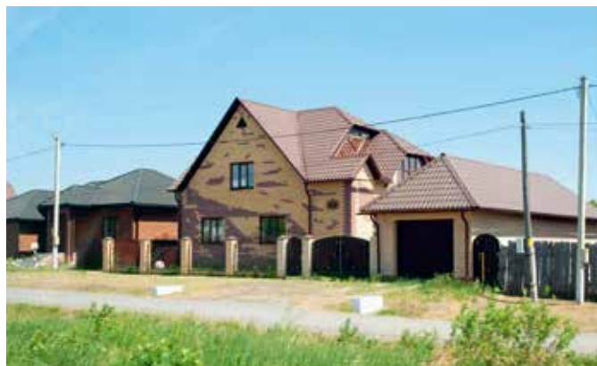
В селе асфальтированы все улицы, кроме двух, отсыпанных щебнем
