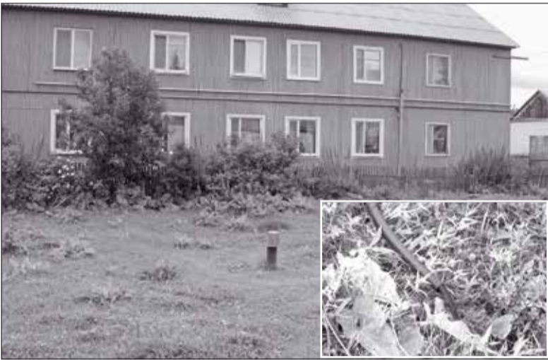
Из дома по улице 8 Марта канализационные отходы сливают в близлежащую канаву. Не важно, что «аромат» на всю округу стоит – главное, экономят
