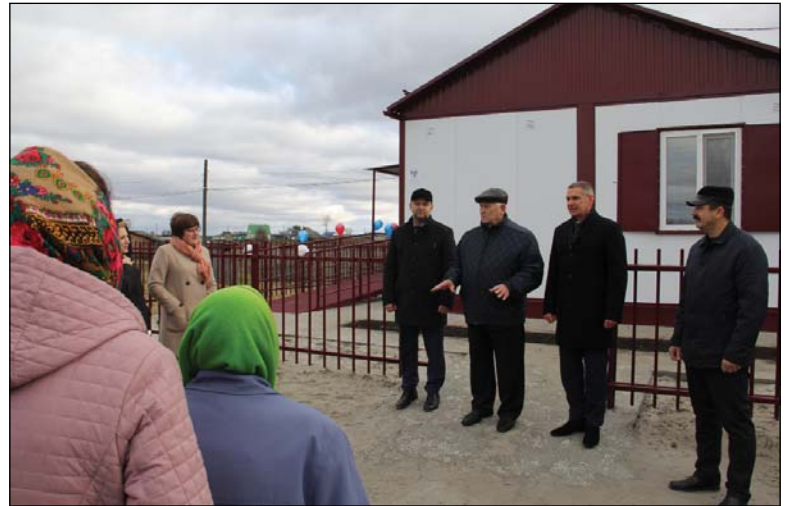
• Слободчиковцев с открытием ФАПа поздравили: главный врач областной больницы № 11 Алексей Белов, депутат Тюменской областной думы Юрий Конев, глава Аромашевского района Игорь Власов, глава сельского поселения Виталий Шихов (слева направо).
