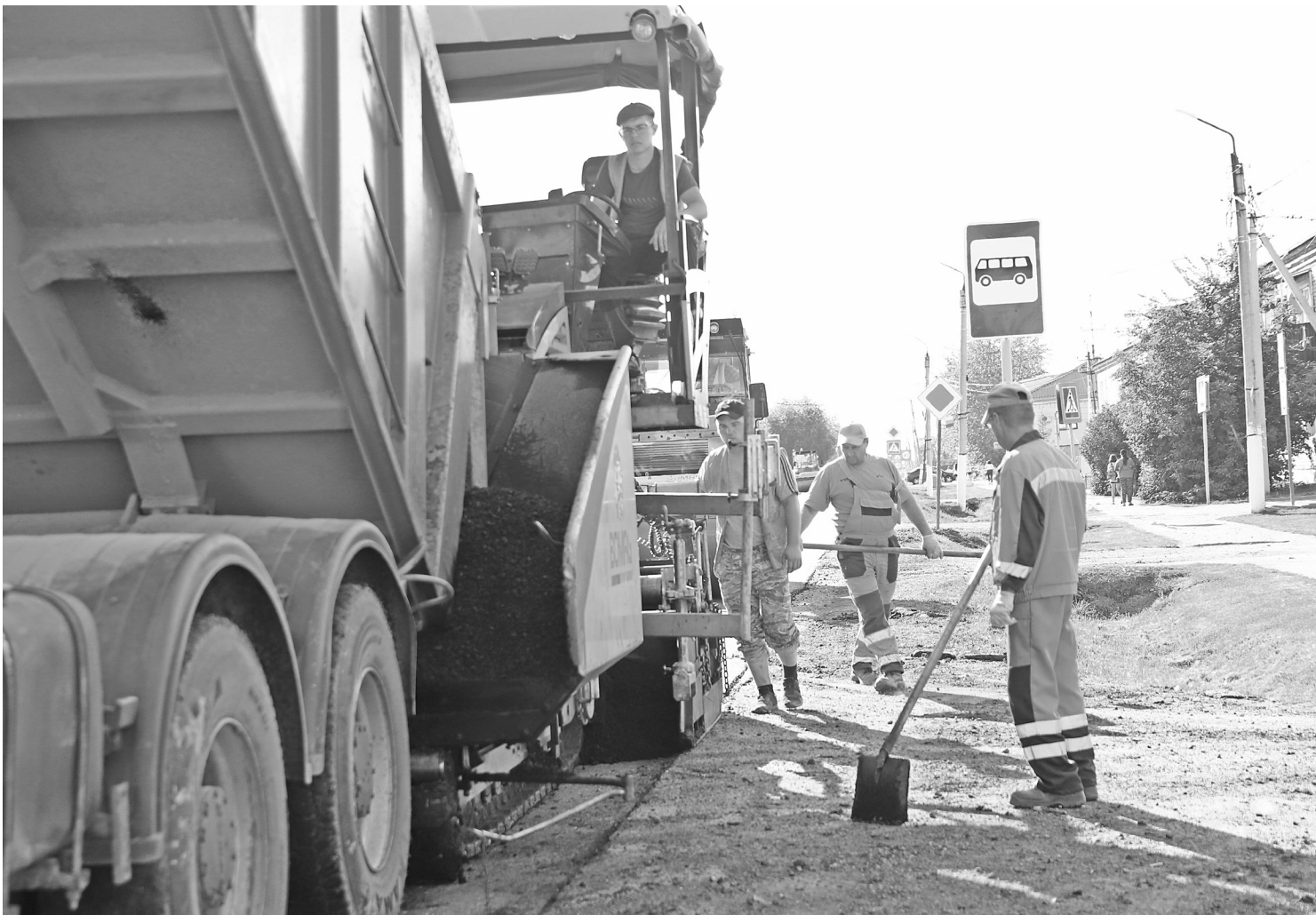
Работники ДРСУ-4 снимают старый слой дорожного полотна на улице Садовой посёлка Голышманово – в тот же день закатали в новый асфальт
