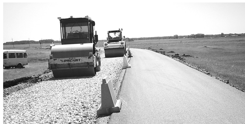
Подъезд к Черемшанке отремонтирован на 75 процентов
