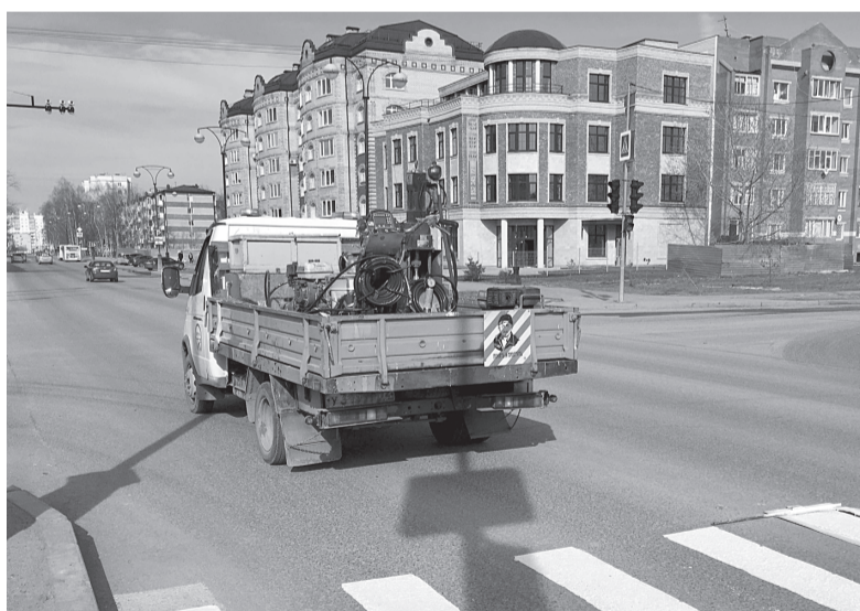
Дорожные работы – в приоритете
