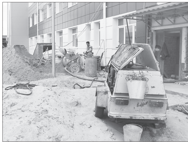
Раствор для стяжки полов подготавливается на улице и по трубопроводу под давлением подаётся в здание
