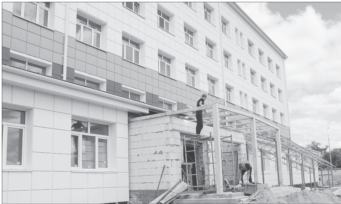
Сейчас строители готовят входную группу к монтажу кровли
