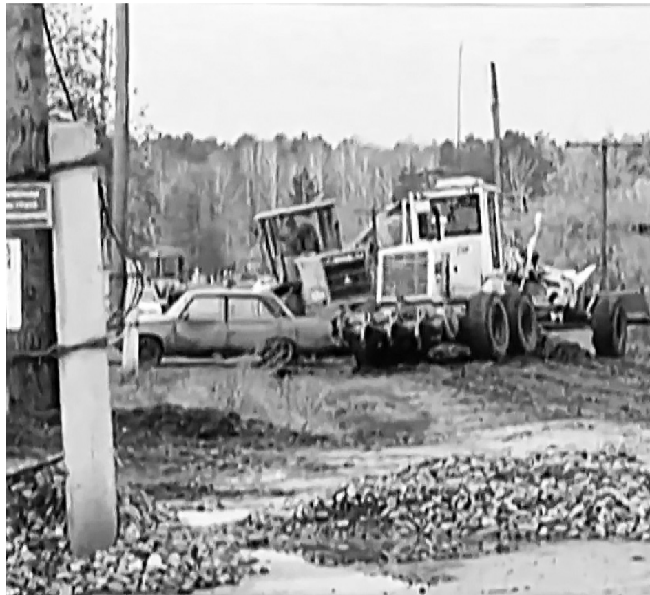
Один трактор не смог попасть по ул. Советской на ул. Дзержинского, где шёл ремонт дороги. На помощь ему пришёл другой трактор. Выбрались, оставив после себя жуткую картину.
