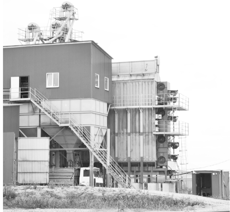
Новый мощный зерносушильный комплекс в селе Ингалинском.
