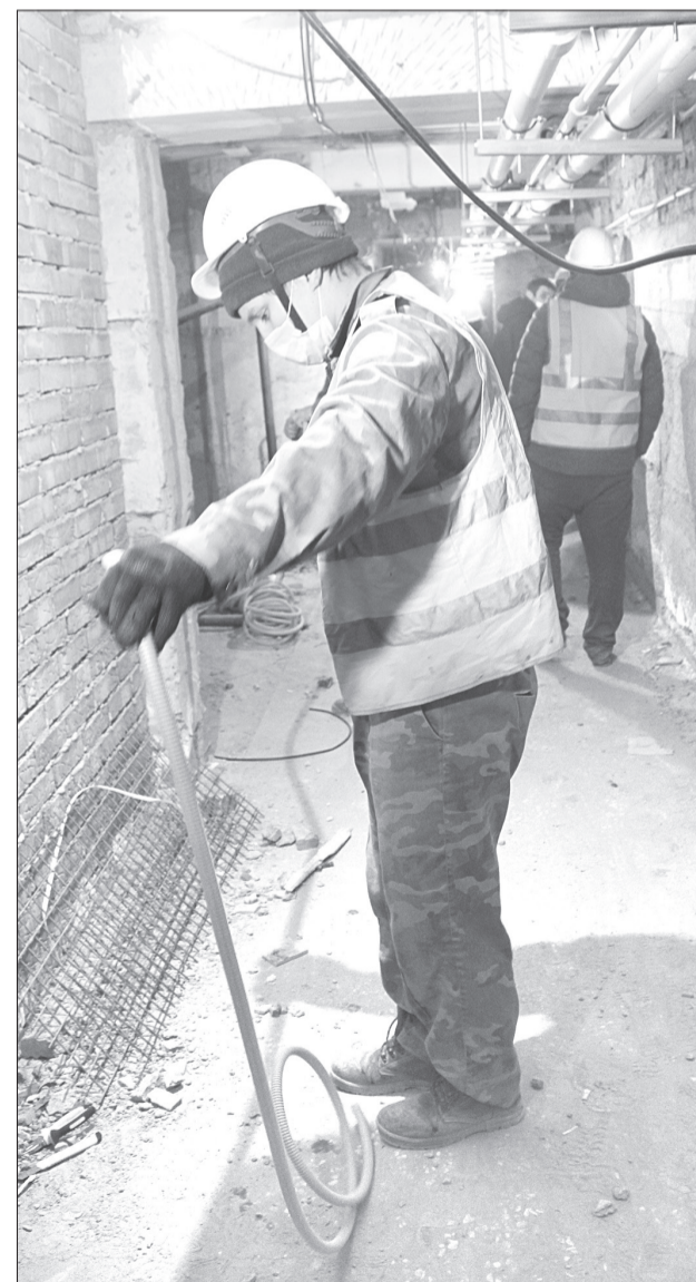
На цокольном этаже сейчас рабочие прокладывают магистральные линии электрической сети /ФОТО АВТОРА
